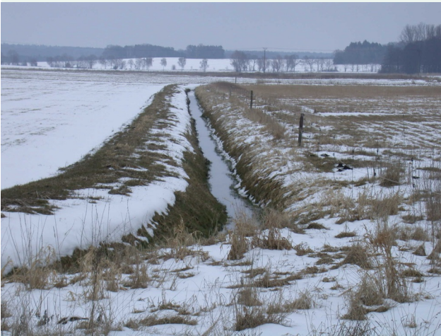
Foto 4: Die Batenser Beeke vor den Ausgleichsmaßnahmen
