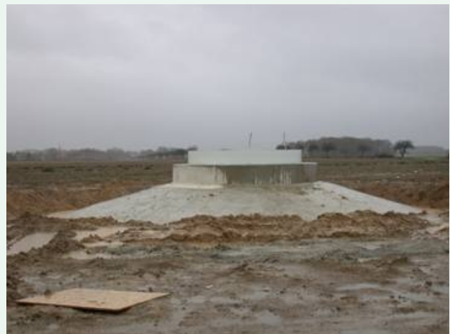
Foto 2: Fundament von WKA Lehmke
