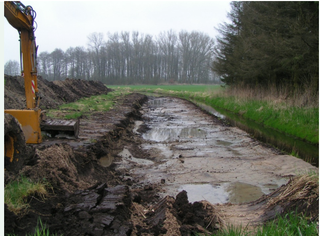
Foto 5: Die Batenser Beeke während der Ausgleichsmaßnahmen
