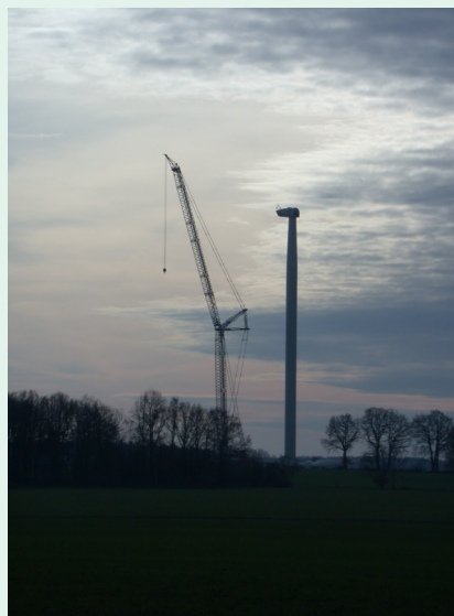
Foto 1: Windkraftanlage Lehmke wird aufgestellt
