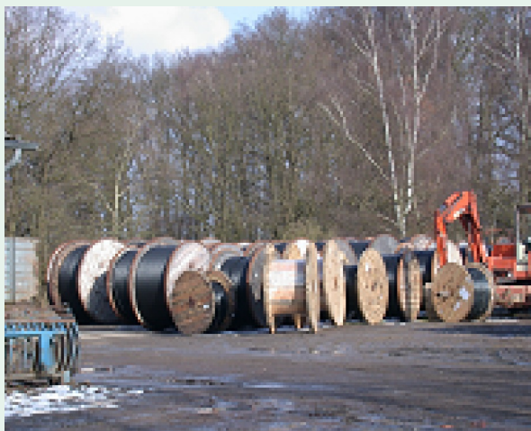
Lieferung der Kabel
