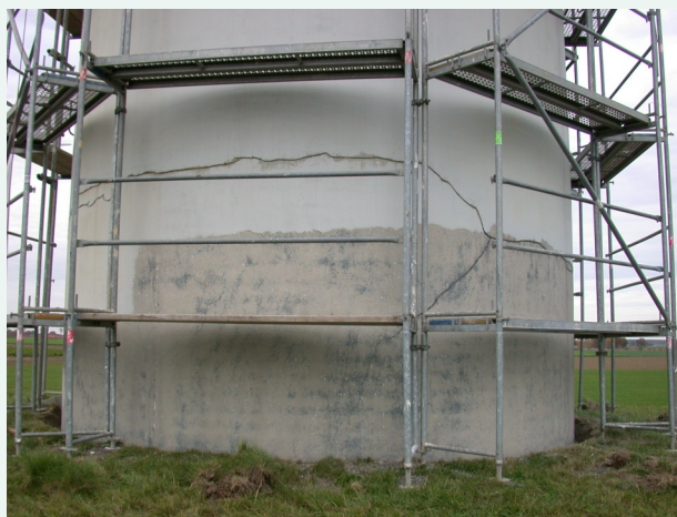
Sanierung des Betonkörpers
