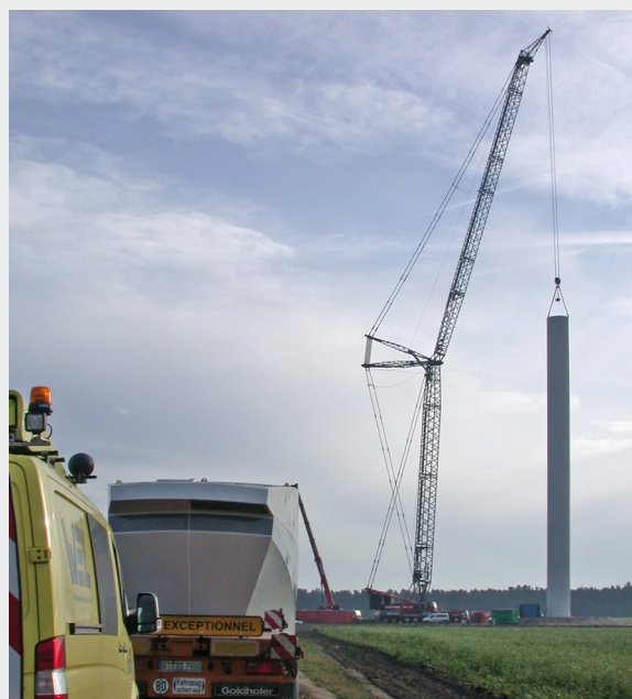
Kran bei der Aufstellung des 1. Turmsegments der Anlage 1
