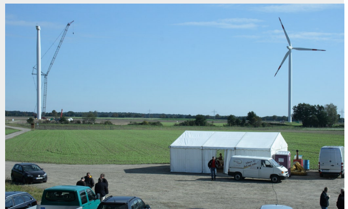
Foto 4: Rüdiger Gerschefski Gesellschafterversammlung vor Ort: links die Anlage des Bürgerwindparks im Bau.
