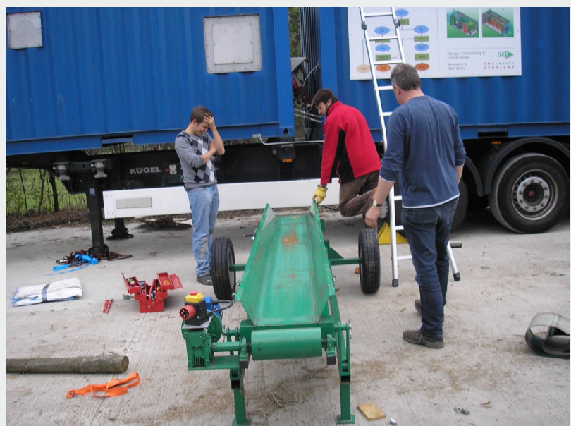
Foto 1: John Corton, Aufbau der Anlage in Wales
